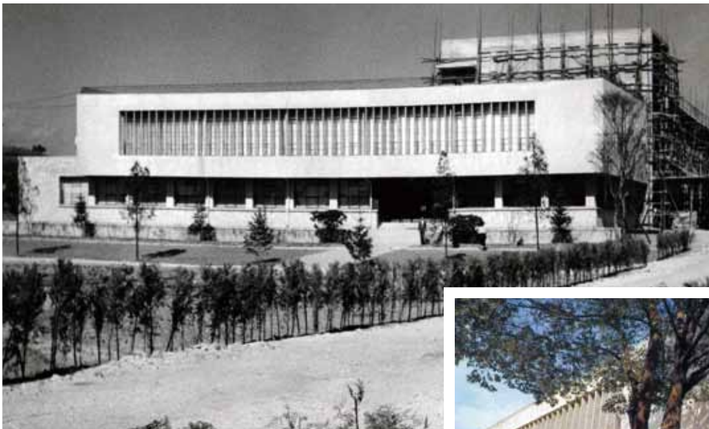
▲ 정치대학 본관(현 문과대 건물) 1950~1960년대
