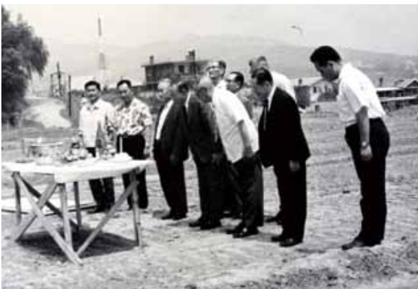
▲ 장안동 캠퍼스 건설 공사 현장 1954~1956
